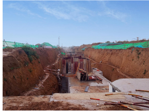
在建韩信路电力管沟
