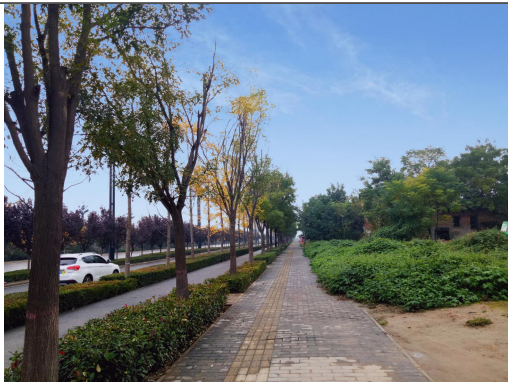
秦汉大道电力管沟
