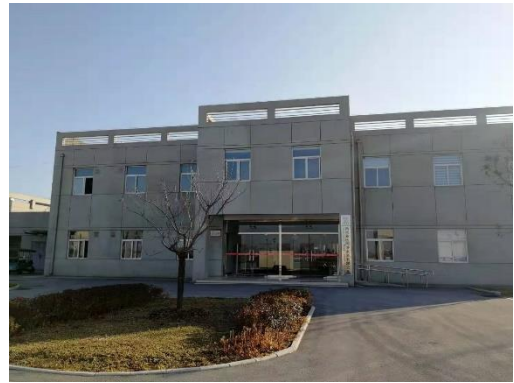
现有综合办公楼
