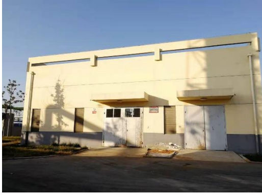
现有鼓风机房
