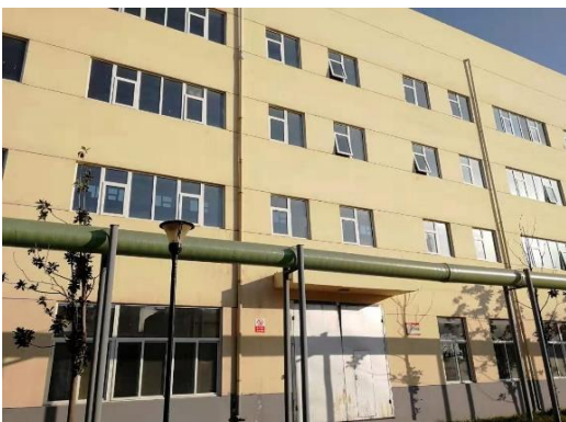
现有污泥脱水间
