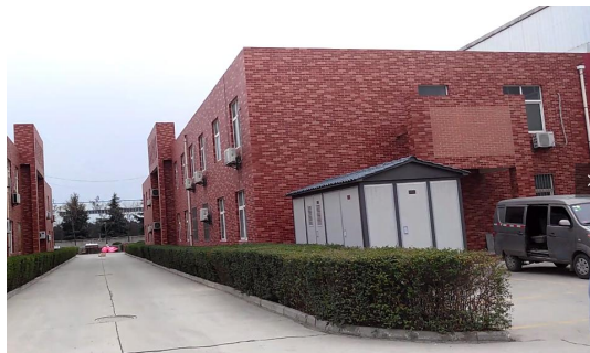
租赁的 2F 综合楼
