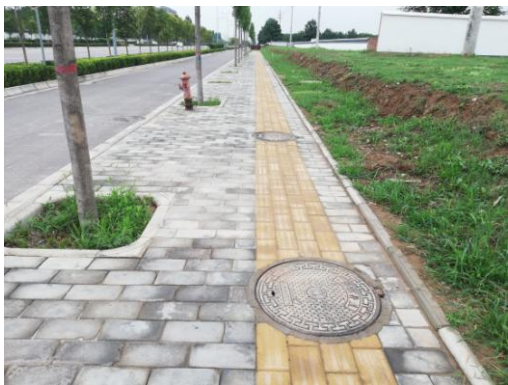
电缆敷设现状 3
