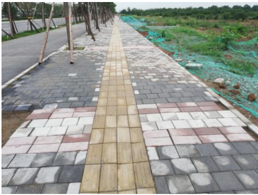
电缆敷设现状 1
