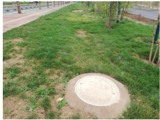
电缆敷设现状 2
