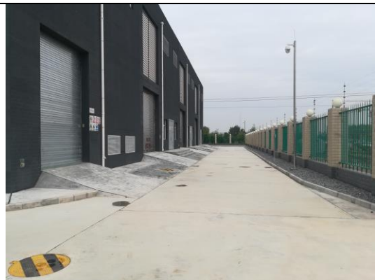
站内道路硬化
