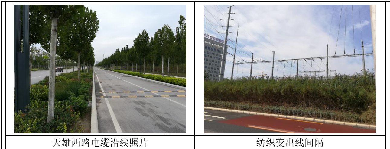
图 3-3 110kV 纺织变~钧台变电缆线路沿线照片
