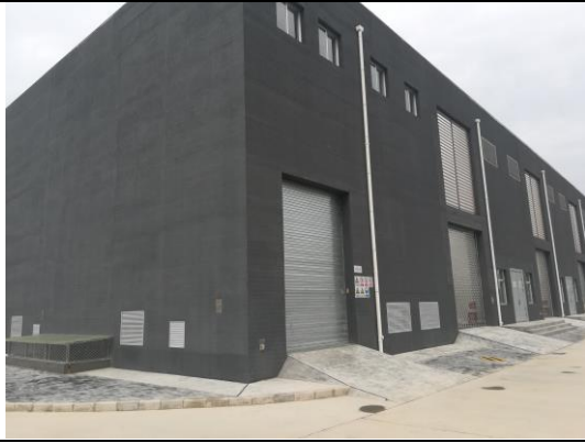
钓台 110kV 变电站综合楼
