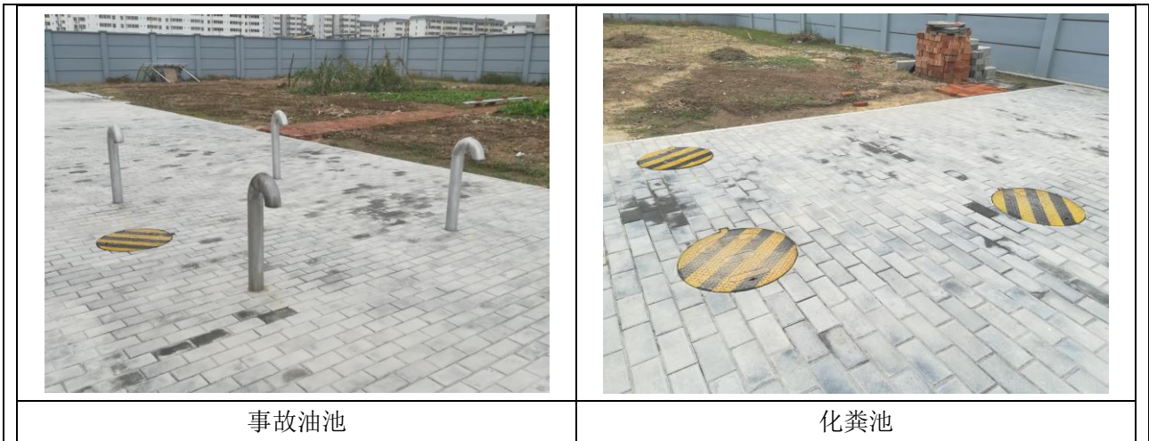
图 3-2 上林 110kV 变电站内照片
