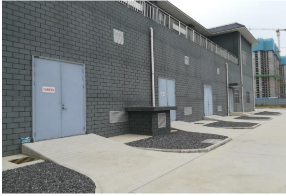
上林 110kV 变电站综合楼
